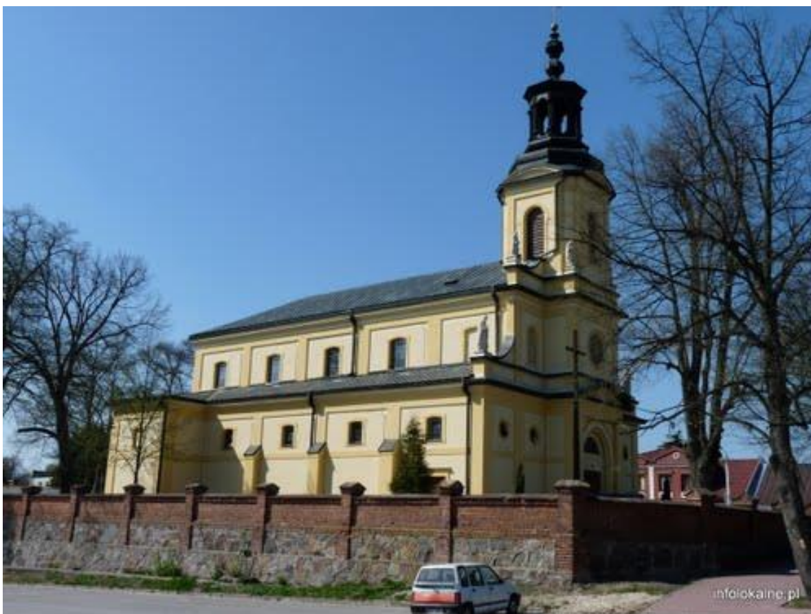
4. Widok od strony południowej.
