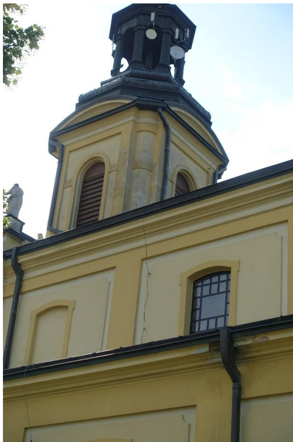
14. Wieża – zmycie i złuszczenie farby.
