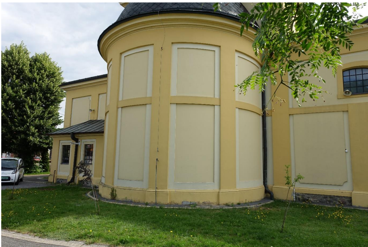
11. Elewacja od strony prezbiterium.
