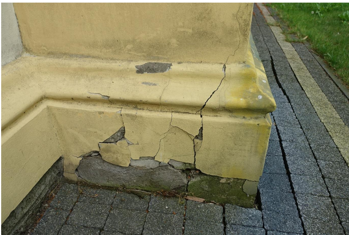
12. Uszkodzenia cokołu.
