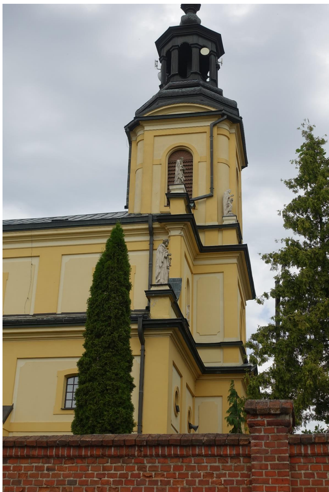
6. Widok wieży od strony bocznej. .
