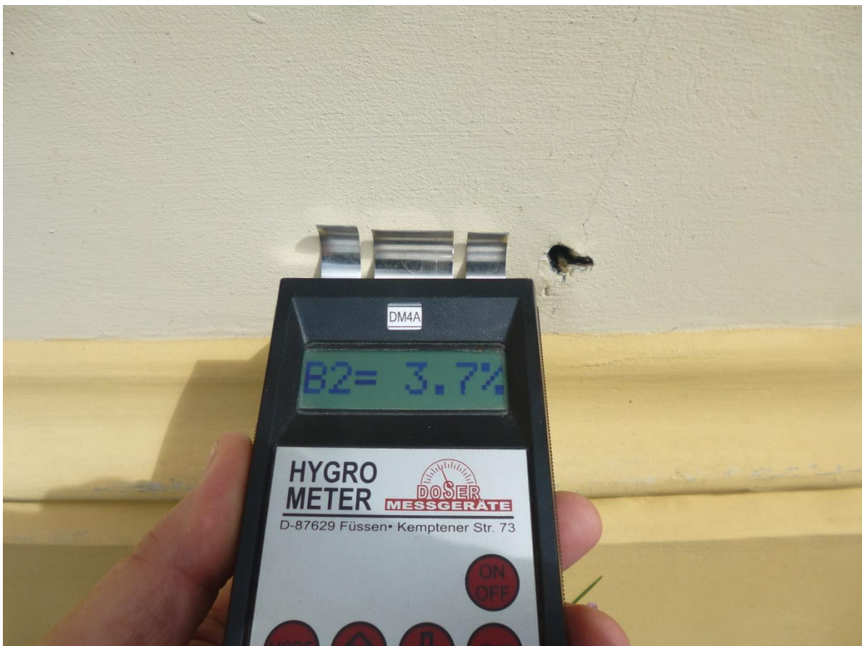
16. Pomiar wilgotności ściany.
